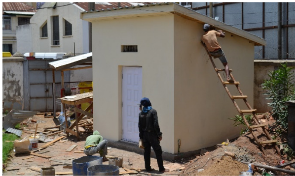
Travaux au dispensaire de Tsaralalana
